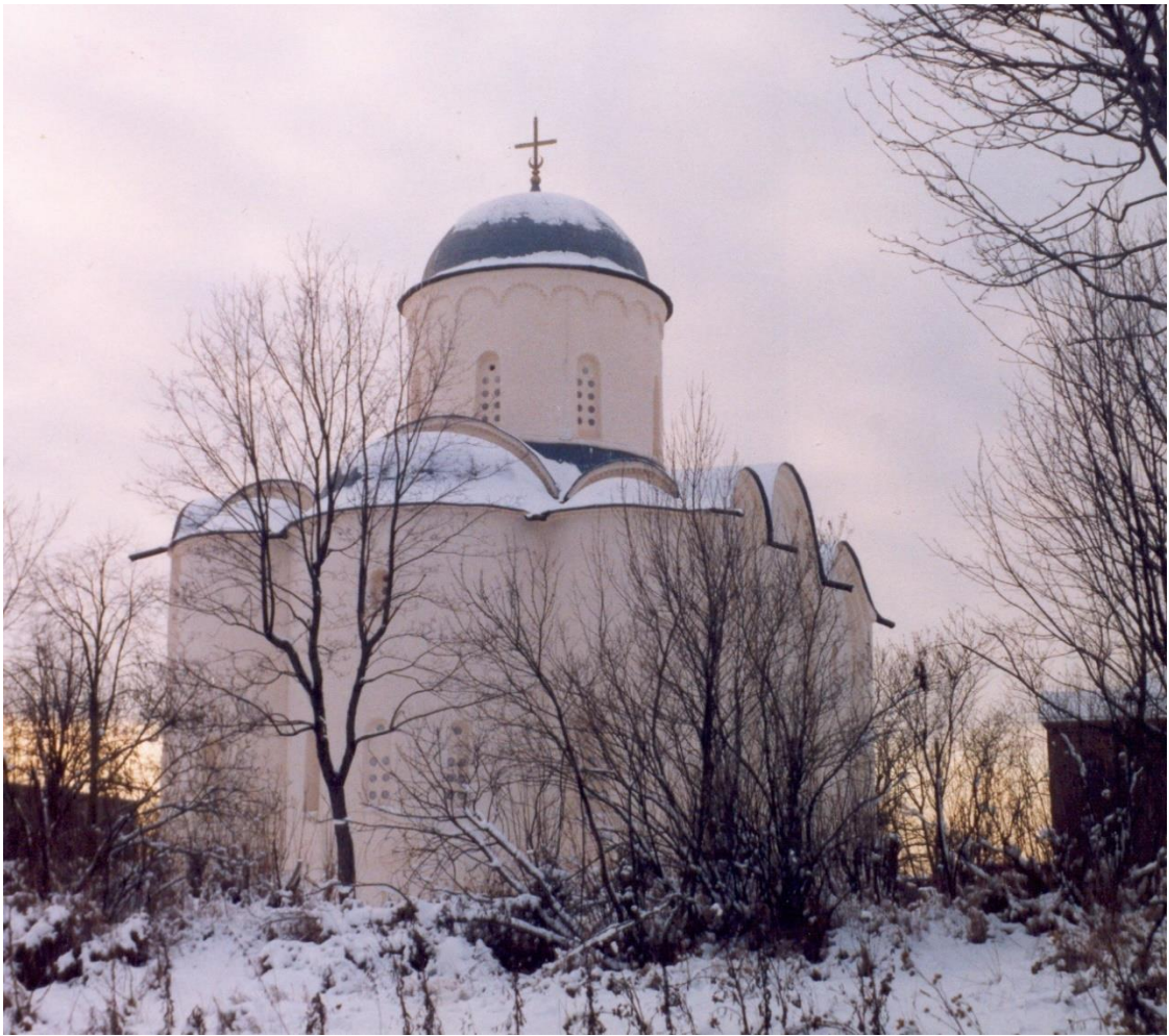
Церковь Успения после реставрации. Фотография Ирины Воиновой. 1999 г.
