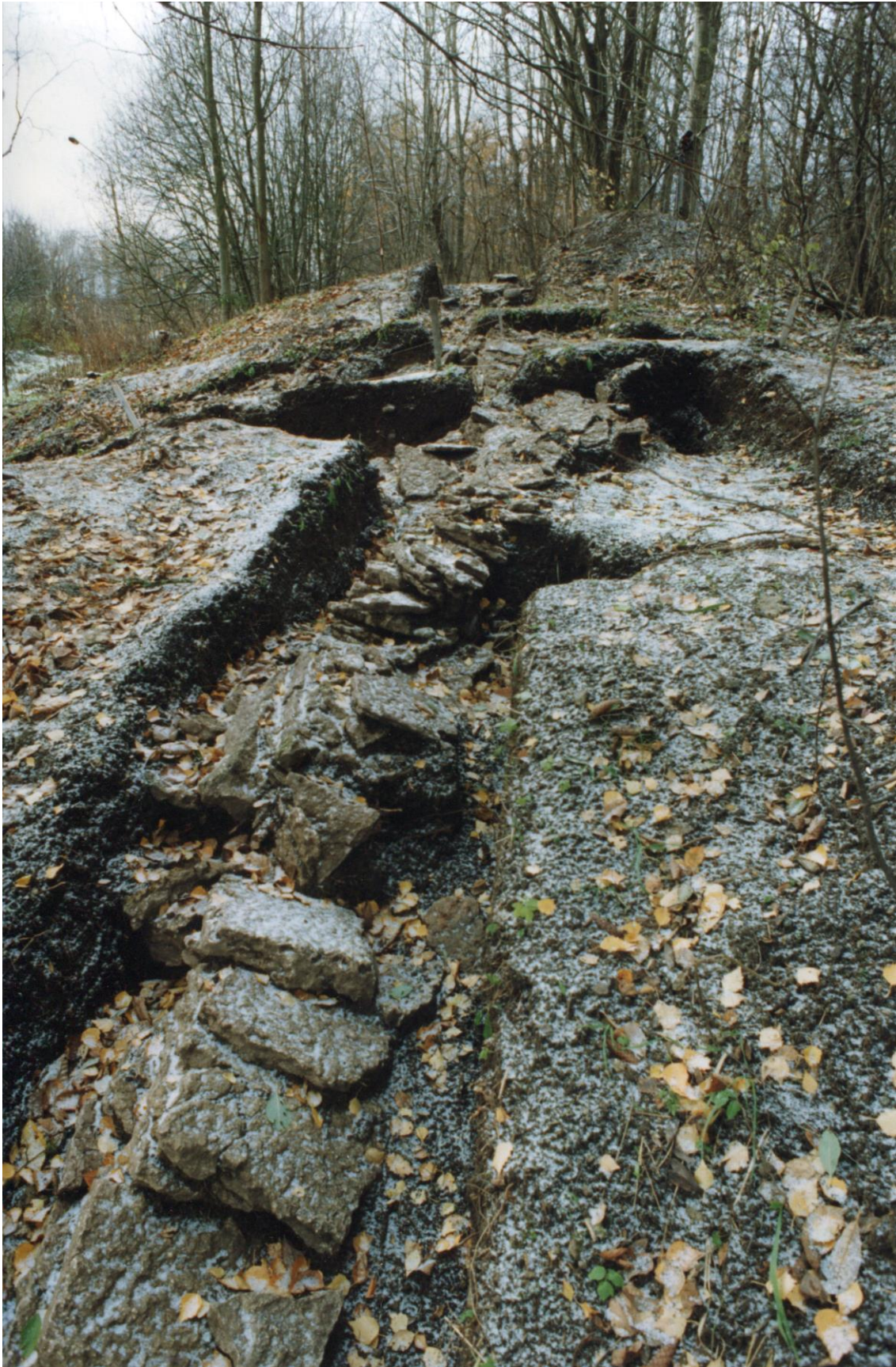
Гребень подпорной стены с напольной стороны крепости
